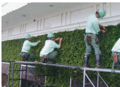
5 植込みを行った後、風で飛ばないように固定します。
