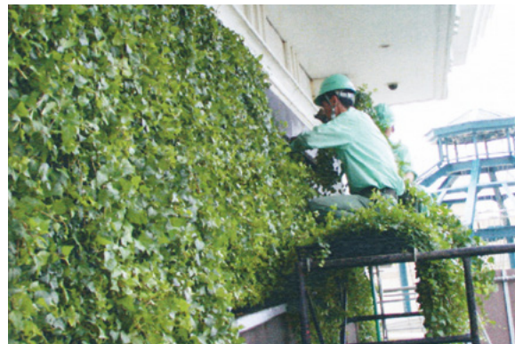
植栽工事の風景。生産地で適切に生育した植物を搬入し、丁寧に植え込みを行います。
