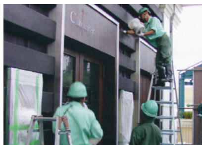
4 灌水システムを設置します。この工事も簡単です。
