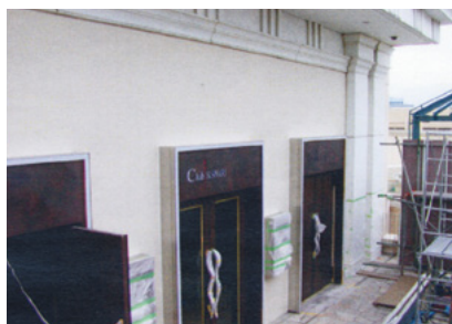
1 施工前の状態です。ここにプランターを設置します。
