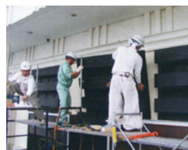
プランター取付工事の風景。軽量な素材特性を活かして、短時間で完了します。
