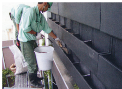
3 植栽土をプランターに詰めていきます。
